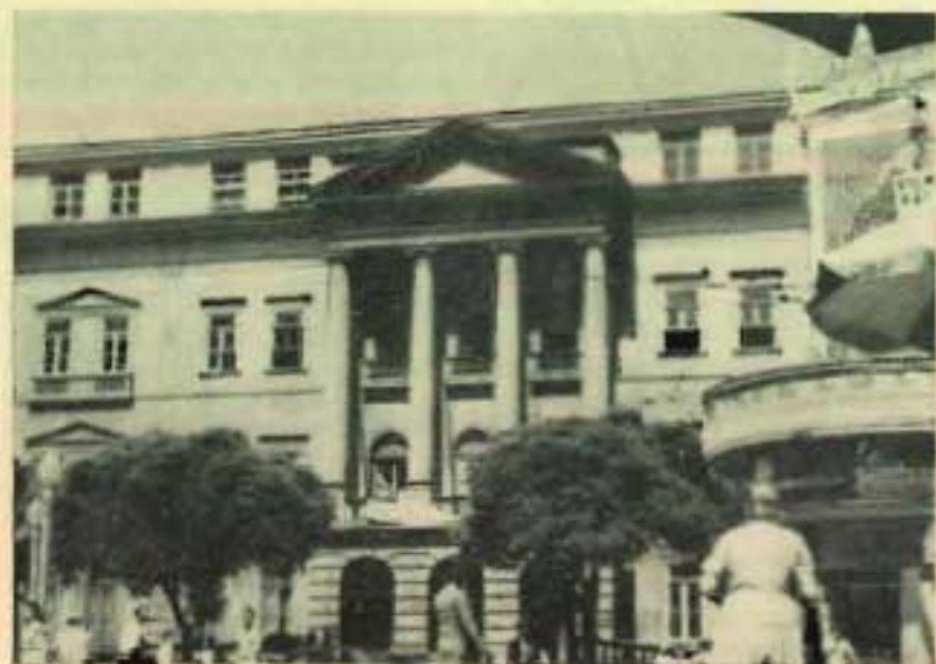
Fachada principal da Escola Nacional de Engenharia.
