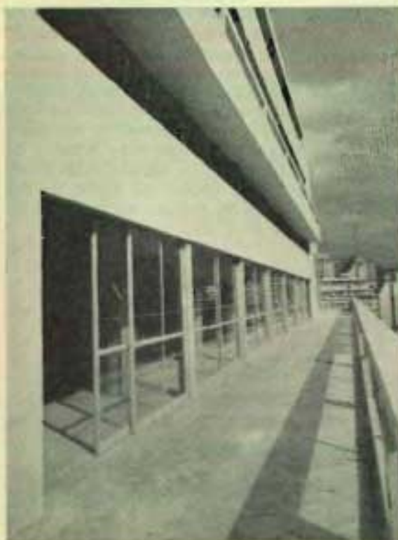
Vista parcial da Varanda do Salão de Festas, no 11º pavimento.
