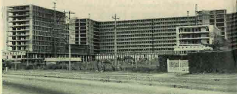
Hospital de Clínicas — obras em andamento.
