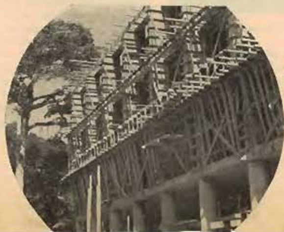
Fase da construção do Centro Técnico Científico.
