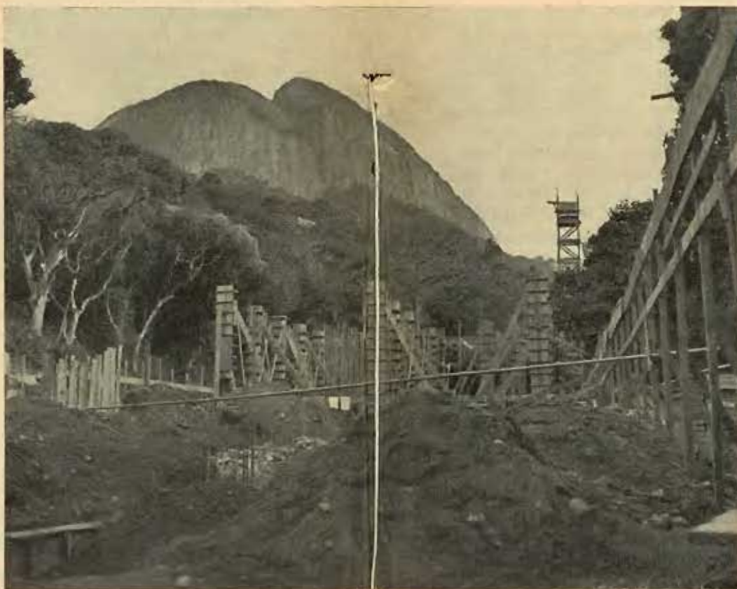
Detalhe da construção da futura sede da P. U. C. do Rio de Janeiro.
