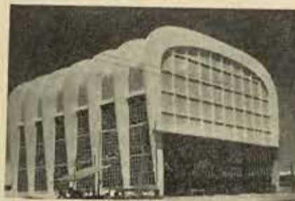
Vista externa do Laboratório de Estruturas.
