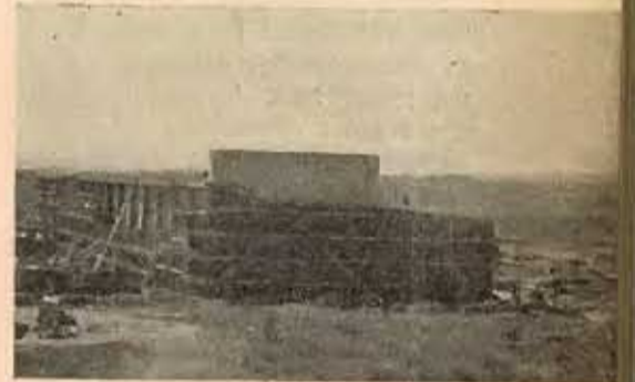
Laboratório de Motores — ainda em obras.
