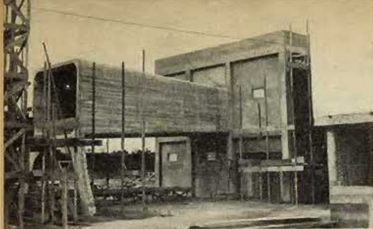
Túnel Aerodinâmico — em construção.
